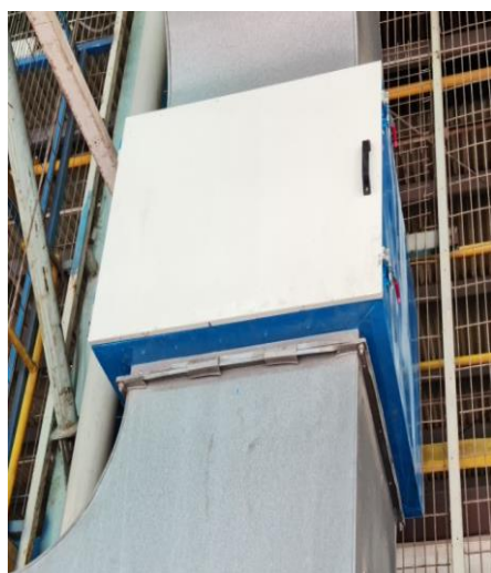
HTXL hợp chất hữu cơ bay hơi (hộp lọc hấp phụ bằng than hoạt tính)
