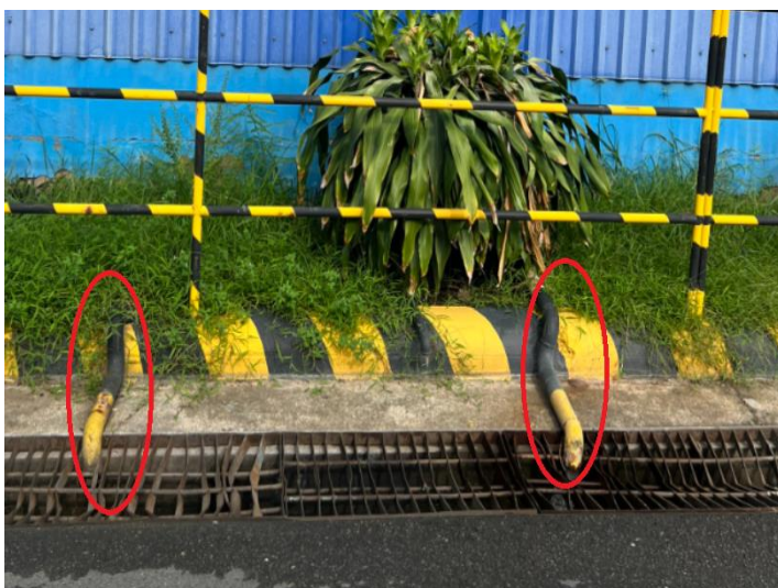
Đường ống thu gom nước thải sản xuất về bể chứa để tuần hoàn
