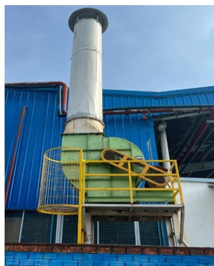
HTXL hợp chất hữu cơ bay hơi (hộp lọc hấp phụ bằng than hoạt tính)
