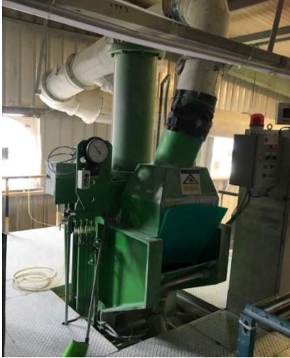
Hệ thống thu gom bụi tại công đoạn nạp liệu, tiếp liệu tại máy trộn (Kneader mixing)
